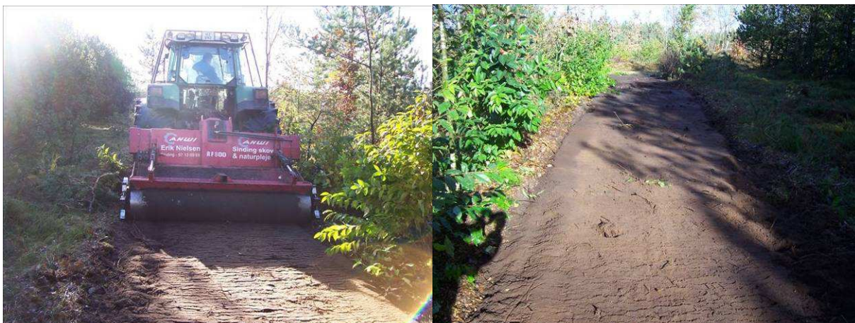
Forsøg med stødfræsning, Herning Kommune. Foto Erik Nielsen.
